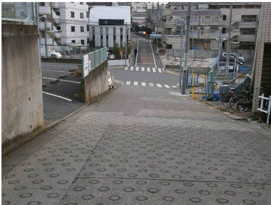
写真1. コンクリート舗装のライフライン工事の埋め戻しの一例
